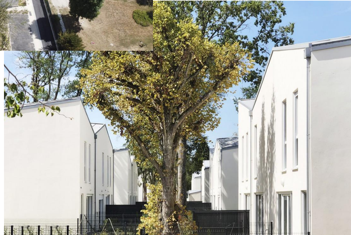
SKP Architecture Résidence de 33 maisons individuelles / LE PERRY EN YVELINES (78) Maître d'ouvrage : TOIT & JOIE
