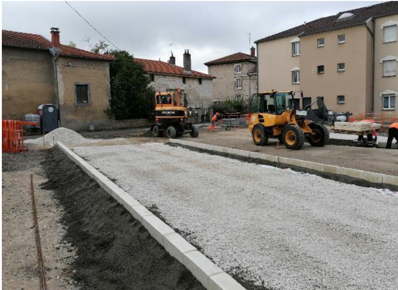
pose des bordures
