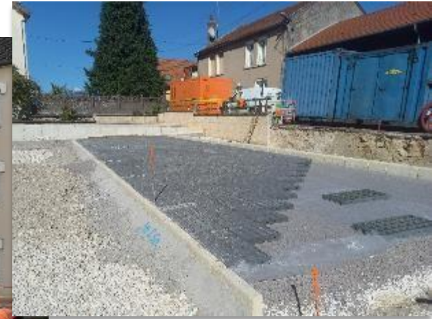
mise en œuvre de la résine drainante
