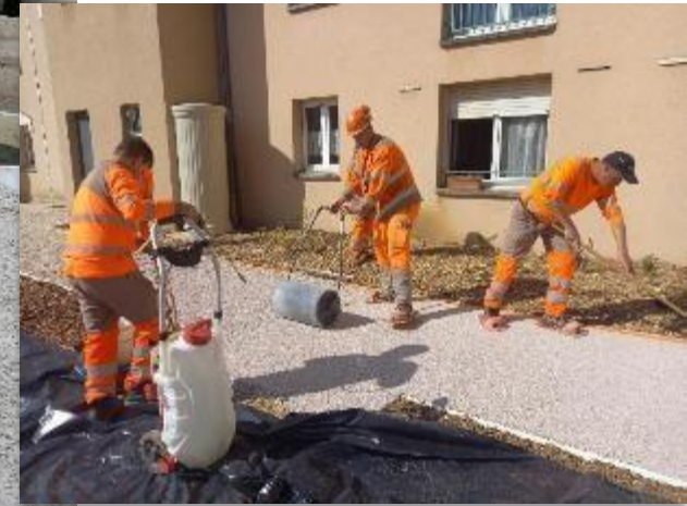
mise en œuvre de la résine drainante
